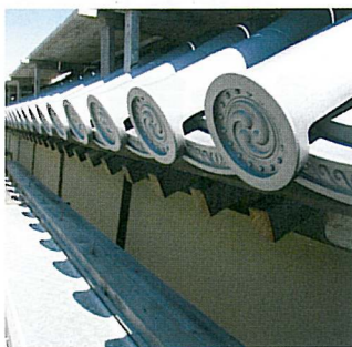
北側築地塀に新しい瓦が葺き上がりました。南側築地塀は木部修復工事を継続中です。
